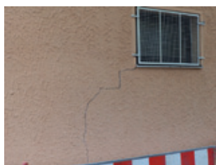
Die Risse im Mauerwerk zeigen sich an den verschiedensten Stellen (Okt. 2015).
