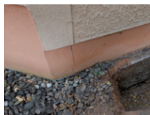
Die Risse im Mauerwerk zeigen sich an den verschiedensten Stellen (Okt. 2015).
