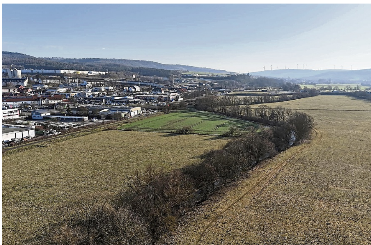
Die Renaturierung der Haune ist eine von insgesamt fünf Ausgleichs- und Ersatzmaßnahmen, die als Kompensation für den Bauabschnitt der A4-Bad Hersfeld-West ausgeführt werden. FOTO: AUTOBAHN GMBH
