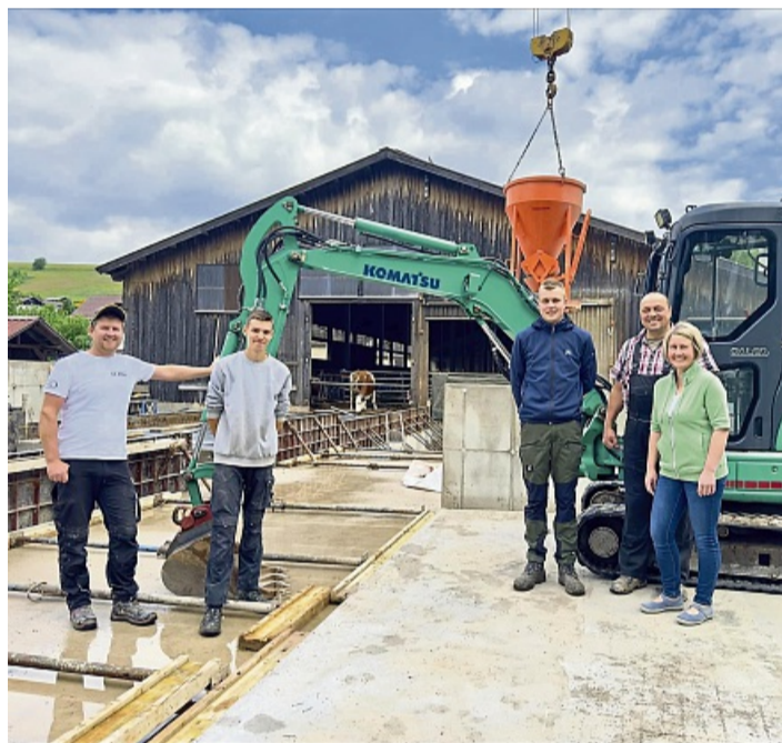
Ein gemeinsames Projekt der Familie: Clemens, Silke und Jörg Schäfer (von links) beim Bau ihres Tierwohlstalls in Niedergude im Juni 2025. ARCHIVFOTO: CAROLIN EBERTH
