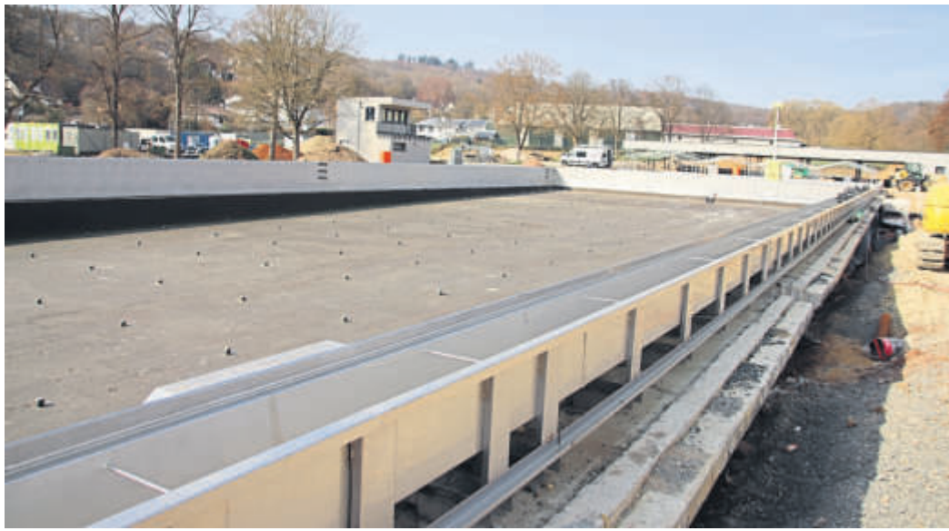
Die Dichtigkeitsprüfung des Schwimmerbeckens ist abgeschlossen.
