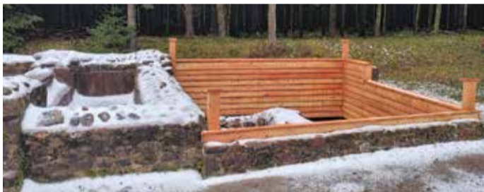
Beim Römerbad in Würzburg wurde die Holzverkleidung des sogenannten „Heizraums“ renoviert.
