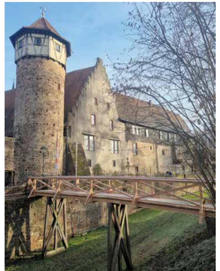
Bei der Burggrabenbrücke wurden Längsträger, Geländerkonstruktion und Bodenbelag erneuert.
