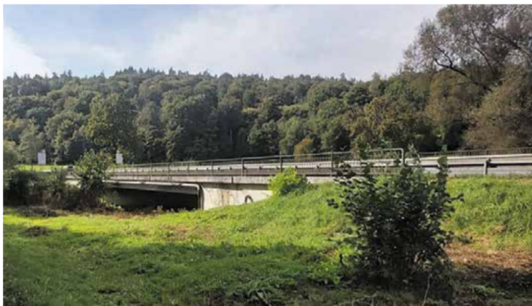
Blick auf die Brücke am Bad Königer Kurpark vor den Bauarbeiten.
