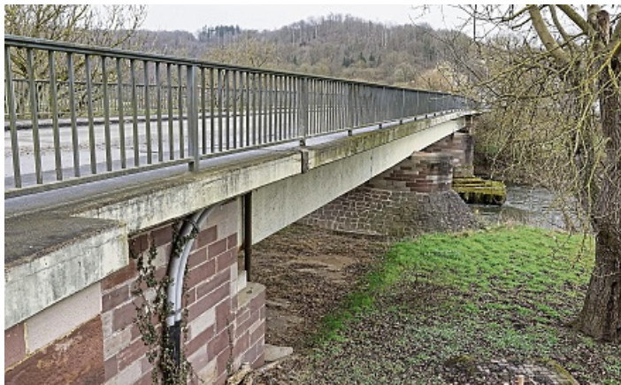
Die Diemelbrücke in Helmarshausen wird Mitte April für zehn Tage gesperrt wegen Bauarbeiten an der Poststraße.
