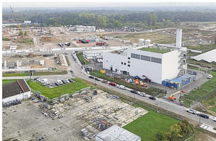
Das Kraftwerk wurde auf dem Gelände der ehemaligen Großauheim-Kaserne gebaut. PATRICK SCHEIBER (ARCHIV)
