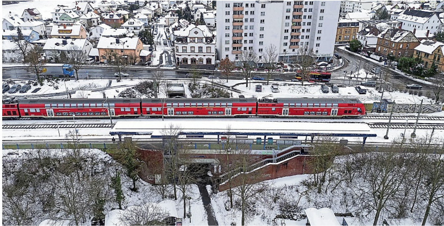
Der Steinheimer S-Bahnhof soll ausgebaut werden. Die Arbeiten werden mehrere Jahre dauern.
