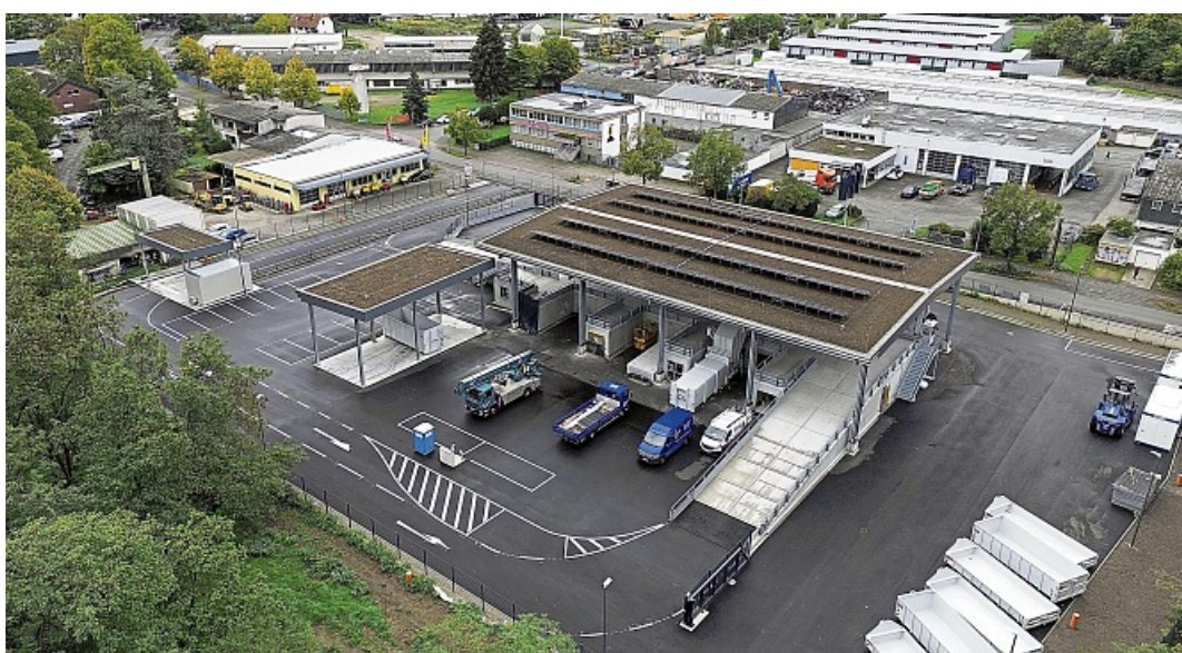
Pro Woche nutzen durchschnittlich rund 1050 Bürger die Entsorgungsanlage an der Benzstraße. Die Zahl ist im Vergleich zum alten Standort gestiegen. PATRICK SCHEIBER (ARCHIV)
