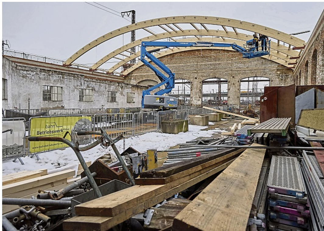
Blick auf die Baustelle: Das neue Dach entsteht.
