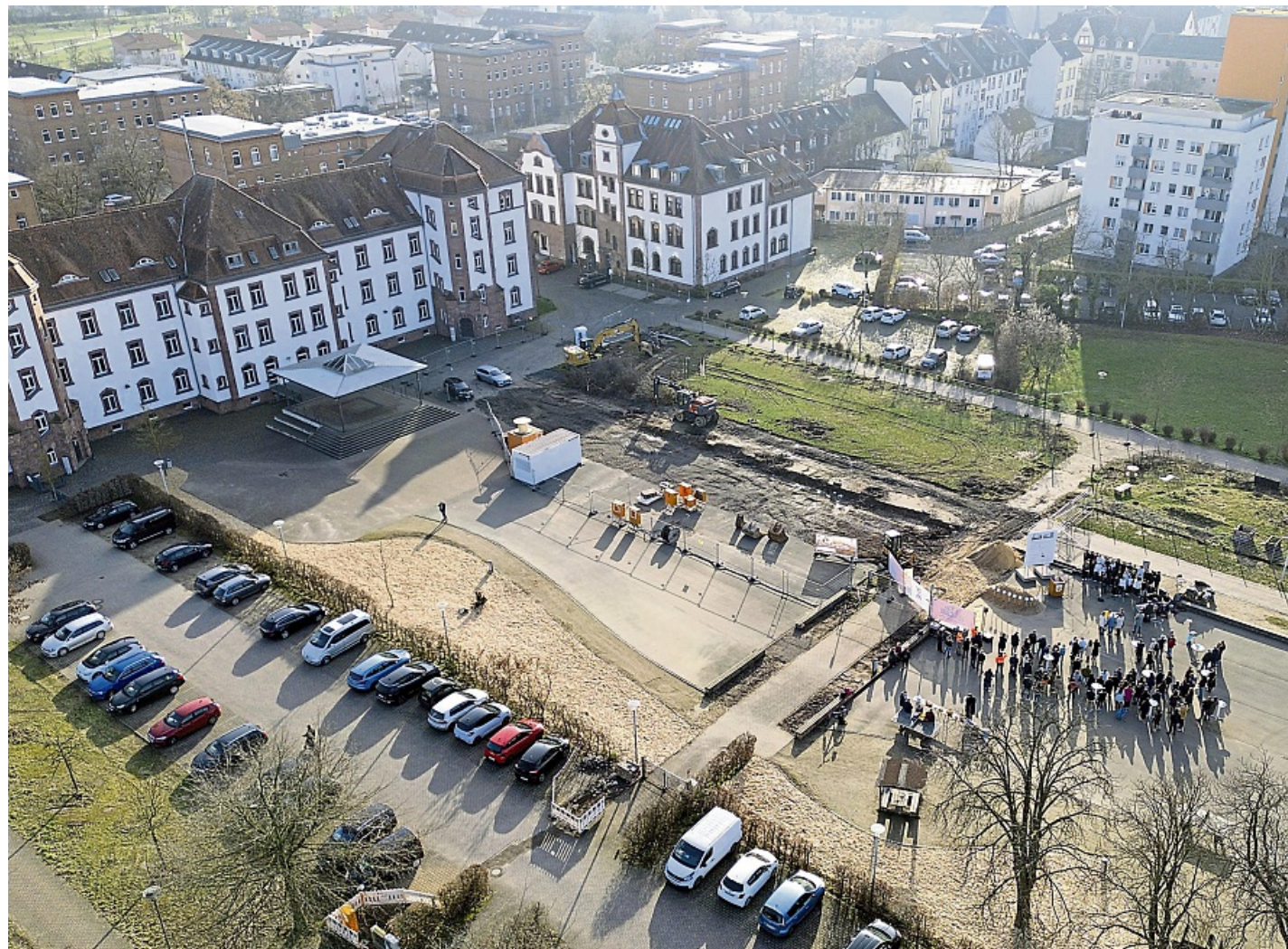
Auf der Freifläche am Hessen-Homburg-Platz wird für 33 Millionen Euro ein Erweiterungsgebäude errichtet. PATRICK SCHEIBER
