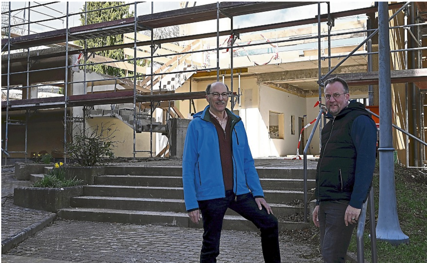
Vor der Baustelle: Fritz Willems (links) und Pfarrer Steffen Blum freuen sich, dass Kosten und Zeitplan bei der Sanierung des Gemeindehauses im Rahmen geblieben sind. FOTO: DENNIS SCHMIDT
