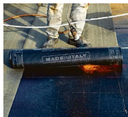
Flachdachsanieierung
