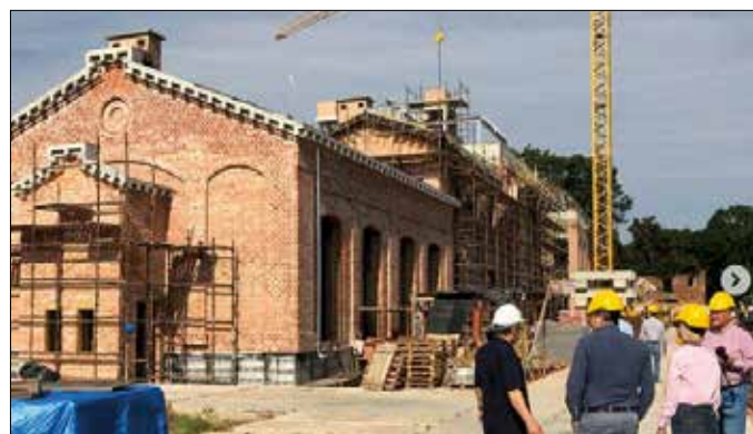
Beginn der Renovierungsphase
