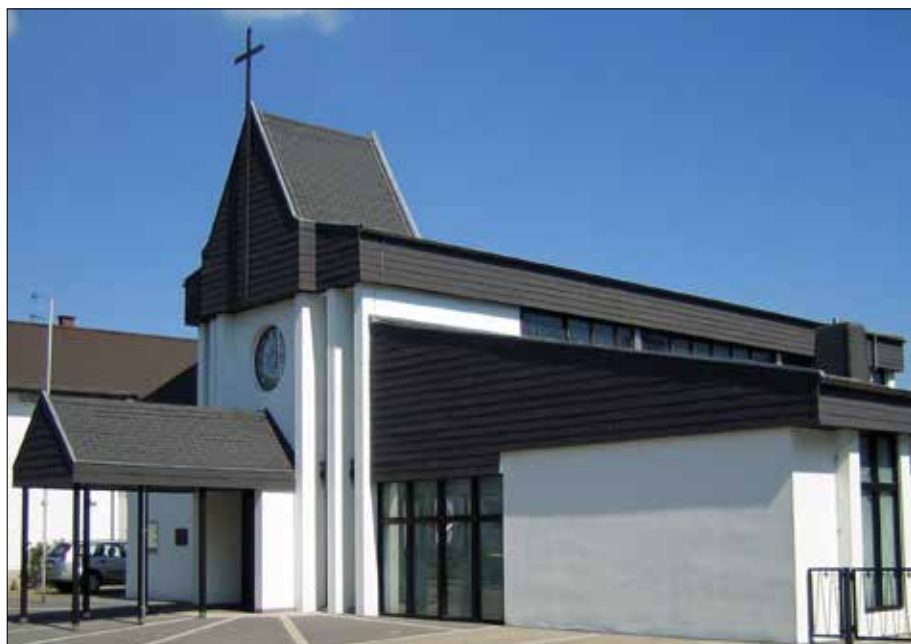
Die katholische Kirche „Heilige Maria – Königin des Friedens“ in Stockstadt wurde von Heimatvertriebenen überwiegend in Eigenhilfe errichtet. (Foto: privat)
