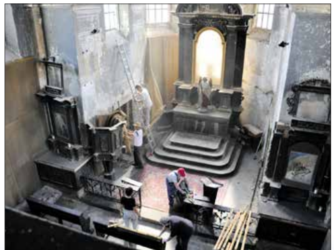
Helfer beim Reinigen im Innenraum der Kirche (Fotos: Omnium)
