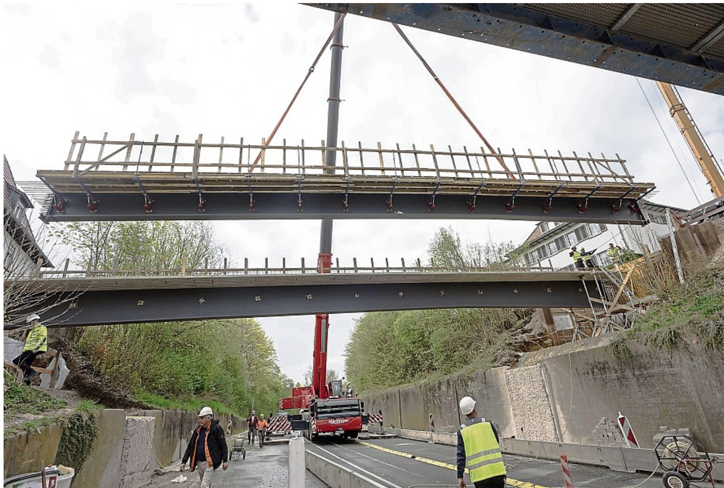
Beeindruckend: Mithilfe eines Spezialkrans werden beide je 30 Tonnen schweren und 28 Meter langen Brückenteile an ihren Platz gebracht. Fotos: Gitta Hoffmann
