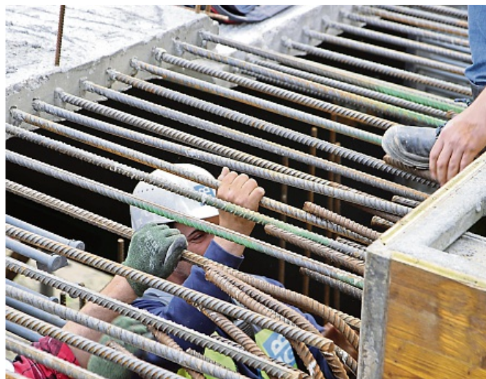
Sorgfältiges Einfädeln: Ben Hiseni und seine Kollegen achten genau darauf, dass sich keine der Stahlstreben verkanten.
