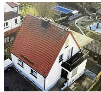
Außenansicht des Hauses vor dem Umbau: Im Hintergrund ist bereits der Pool zu sehen.
