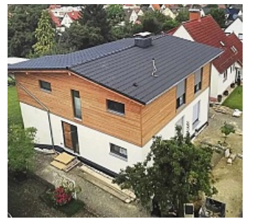
Außenansicht nach dem Umbau: Es fehlen noch die Solarplatten auf dem Dach.
