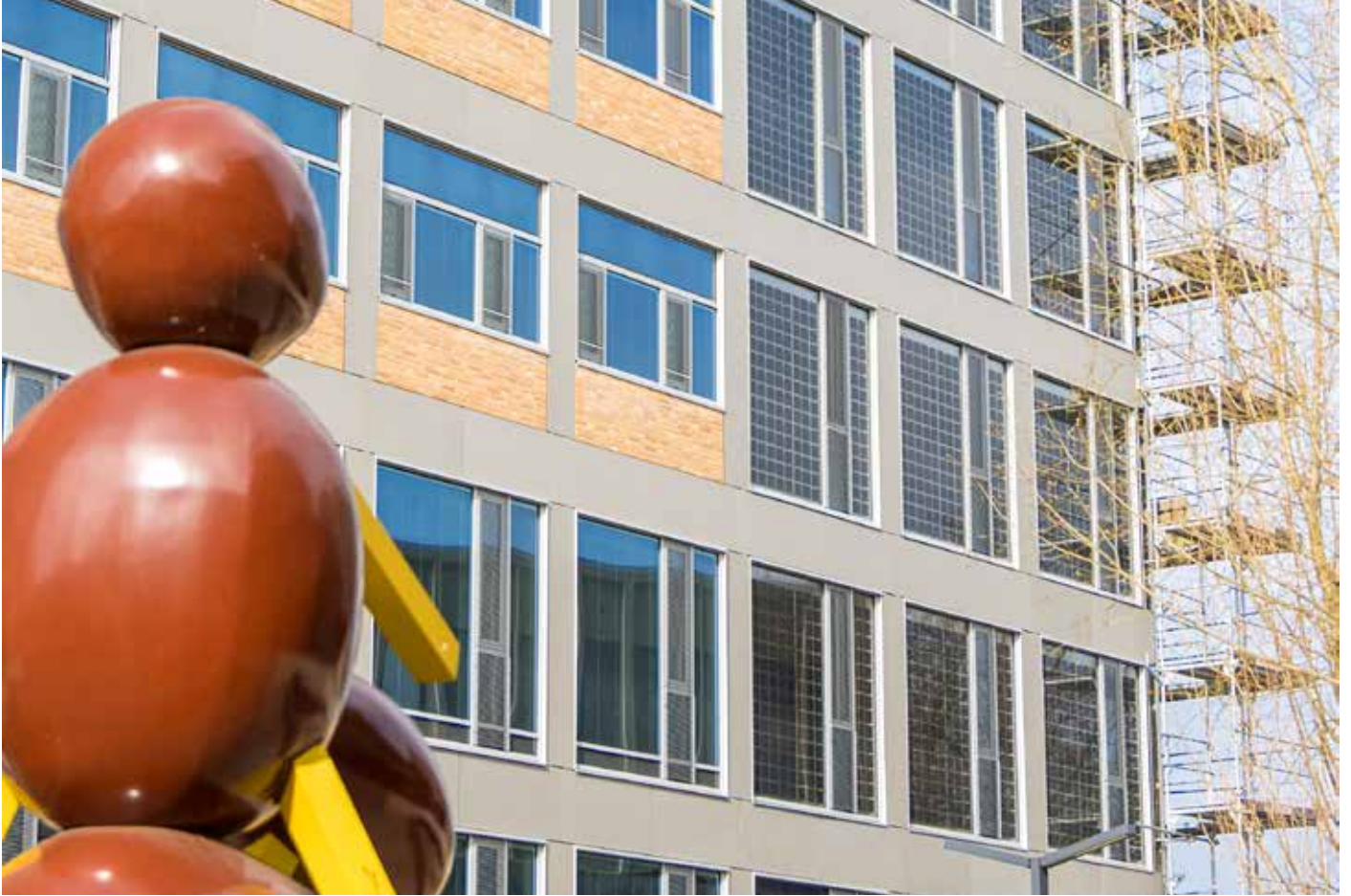
Die energetische Sanierung des Gebäudes C10 schreitet voran: Fenster und Fassade werden erneuert, auf dem Dach und auch in Teilen der Fassade ist bereits Photovoltaik installiert.
