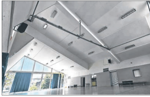
Die raumlufttechnischen Anlagen der Dattenbachhalle werden saniert. Foto: Stadt Eppstein
