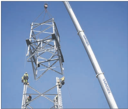
Montage einer Masterhöhung für eine Gleichstromtrasse. Foto: www.amprion.net
