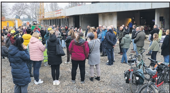
Zahlreiche Nachbarinnen und Nachbarn, Projektbeteiligte sowie interessierte Bürgerinnen und Bürger nutzten die Gelegenheit, sich ein Bild vom Baufortschritt zu machen und diesen wichtigen Meilenstein gemeinsam zu begehen.
