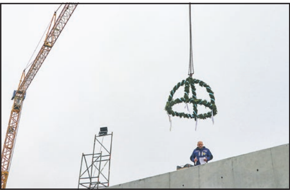
Der traditionelle Richtspruch der Handwerker der Firma W. Trautmann GmbH, vorgetragen vom Polier Steffen Neuberger
