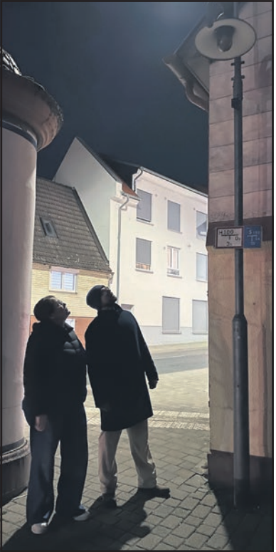
Sabine Kalle und Ruben Leinberger vor den defekten Laternen in der Untergasse
