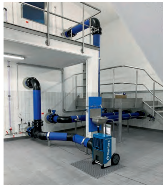
Technische Ausrüstung – Rohrleitungsinstallation
