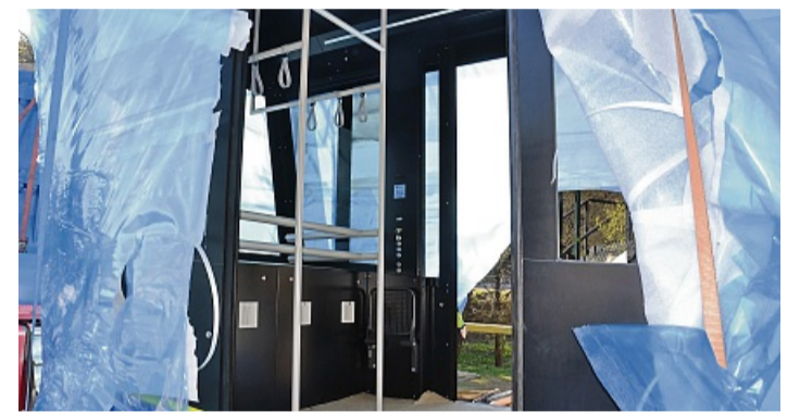
Der frisch ausgepackte Mühlenkopfliner ermöglicht einen Blick in die Kabine.
