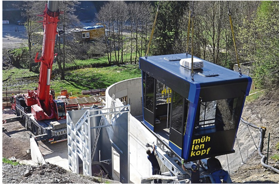
Der Mühlenkopfliner ist auf seinen Schienen angekommen.
