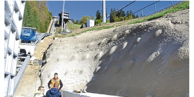
16 Meter Betonwand sind zur Hangabsicherung nötig – die letzten sieben davon unter der Erde: Wegen der Barrierefreiheit liegen die Schienen tief.
