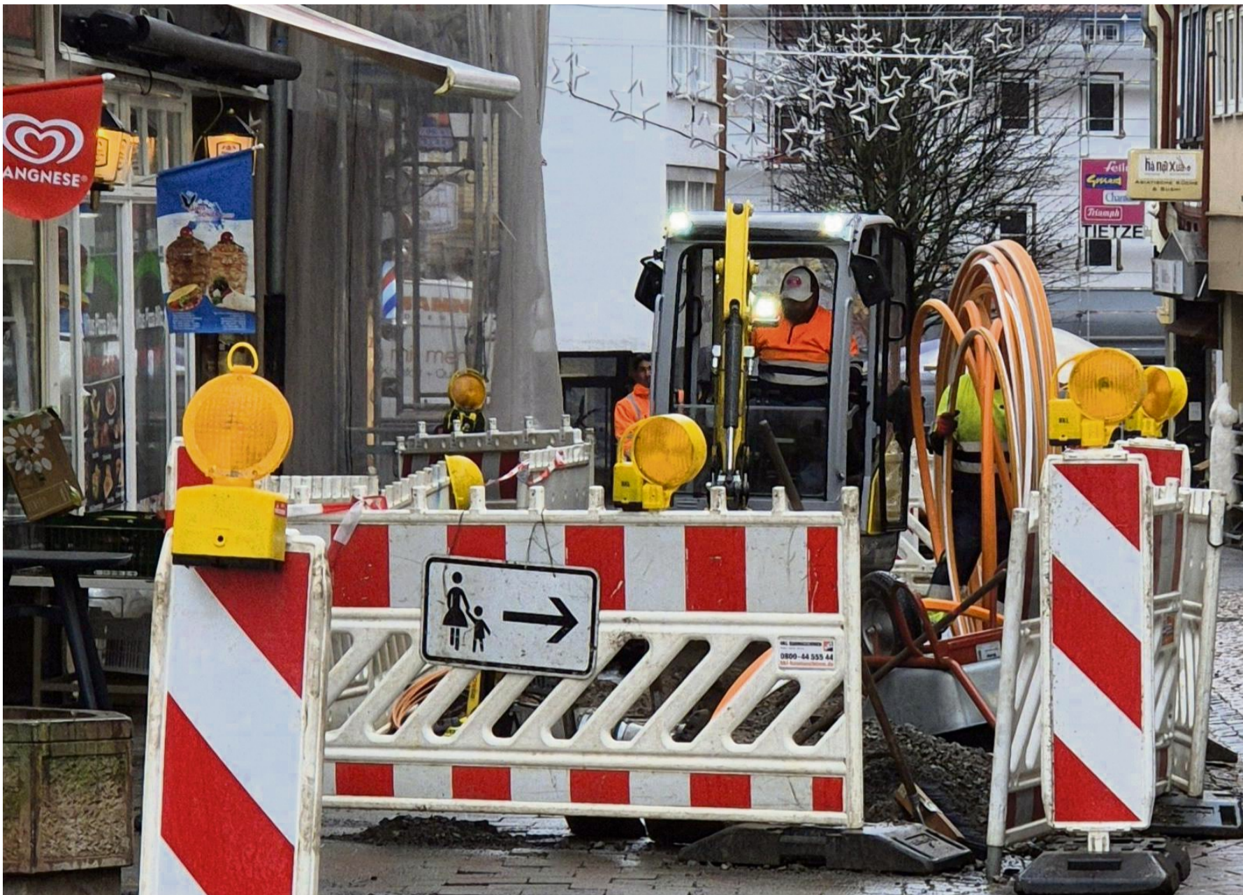
Glasfaser Ausbau schnelles Internet Telekom Baustelle Innenstadt Fußgängerzone Eschwege
