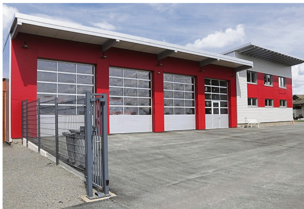
Das sanierte Feuerwehrgerätehaus in Haina: Die Kosten belaufen sich auf rund 1,9 Millionen Euro. „Damit sind wir im Kostenrahmen geblieben“, sagt Bürgermeister Alexander Köhler. Foto: mjx
