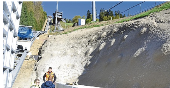
16 Meter Betonwand sind zur Hangabsicherung nötig – die letzten sieben davon unter der Erde: Wegen der Barrierefreiheit liegen die Schienen tief.
