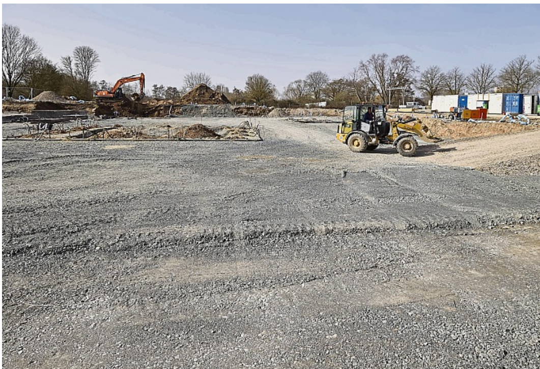
Unter der Schotterdecke stecken 700 Betonsäulen im Boden, um die Tragfähigkeit zu verbessern.
