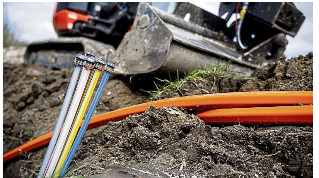
Startschuss für Tiefbauarbeiten: Die OXG Glasfaser GmbH will im Mai anfangen zu graben (Symbolbild). SINA SCHULTDT/DPA
