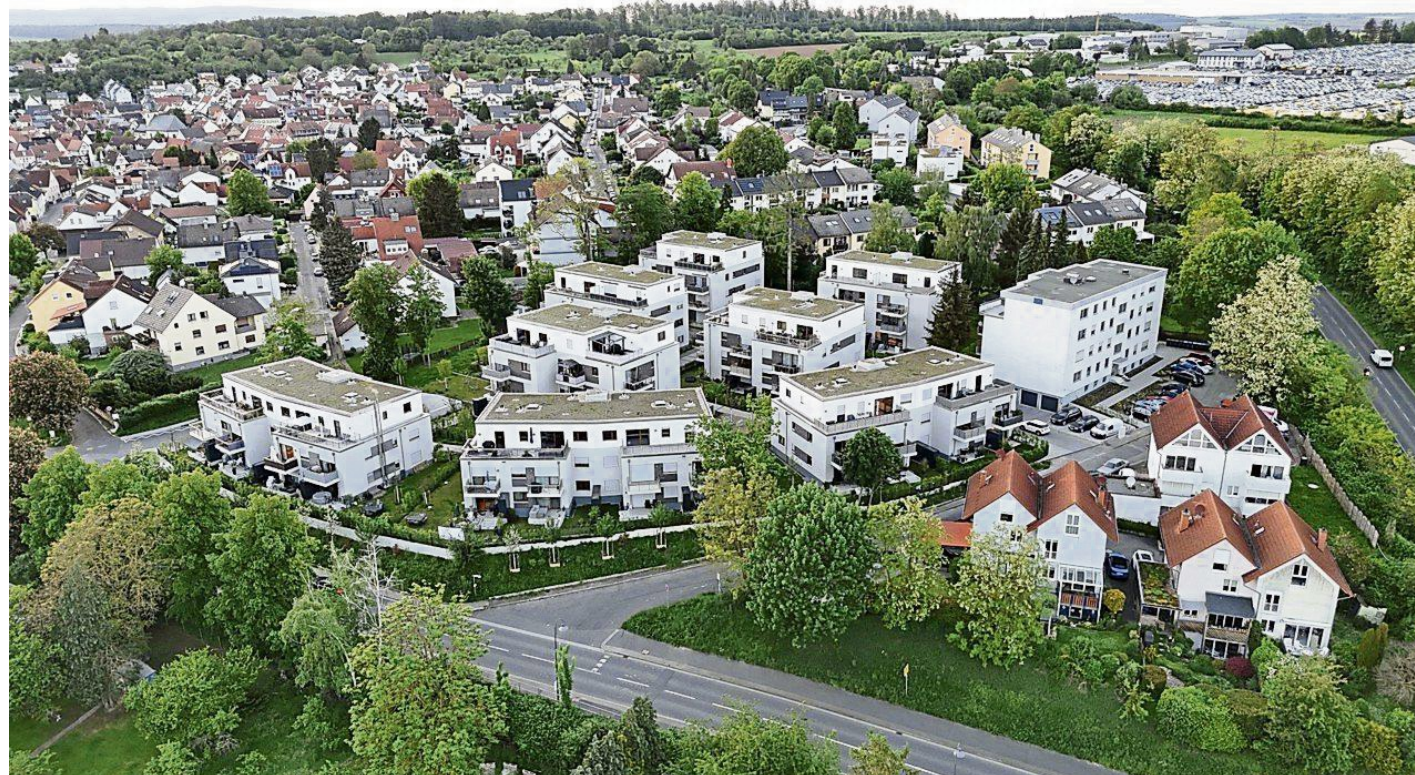
Acht Mehrfamilienhäuser bilden die Wohnanlage Kilianshöhe am Ortseingang von Kilianstädten. Immer wieder kommt es zu Ausfällen der Internetversorgung. Das frustriert die Bewohner.
