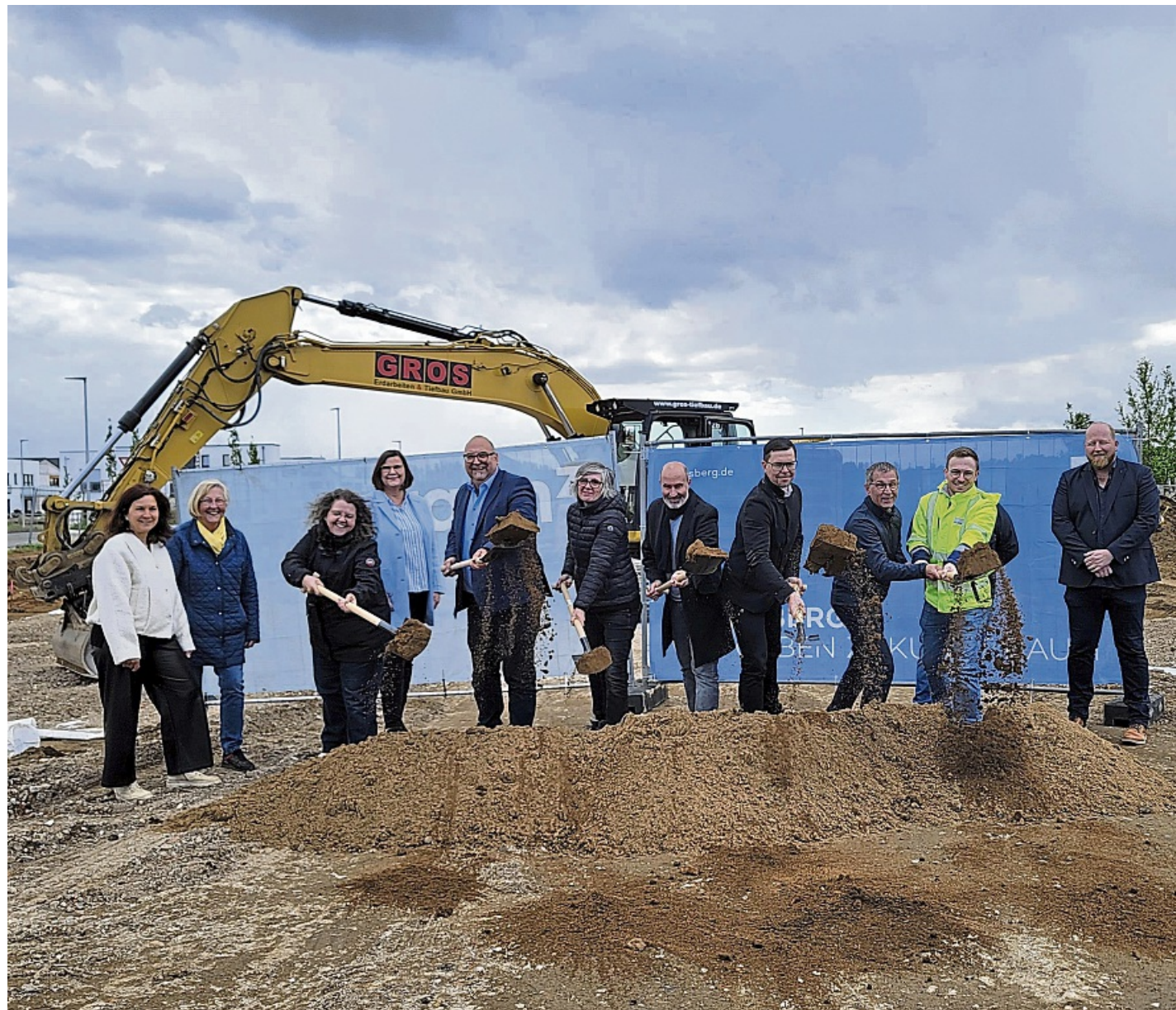
Trübes Wetter, aber beste Stimmung: Die Projektbeteiligten am Neubau der Kita Sonnenwiese beförderten mit Schwung die erste Erde aus dem Boden. Im Juli sollen die ersten Gebäudemodule errichtet werden. PATRICIA REICH
