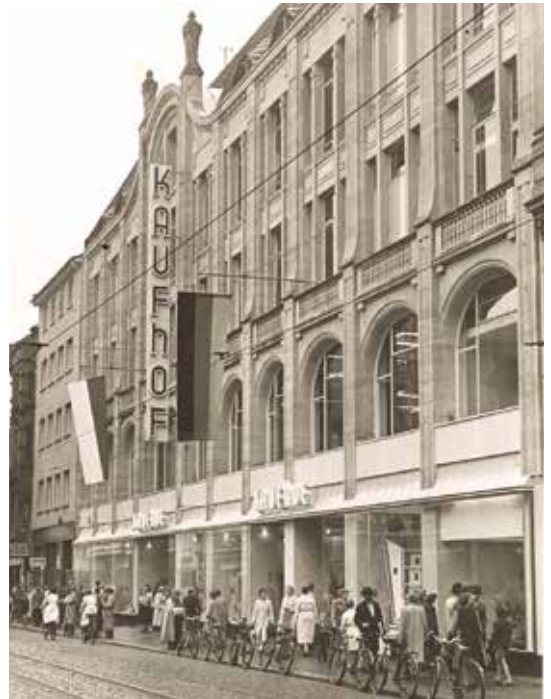
Vor dem Dachumbau Anfang der 50er Jahre. Foto: W. A. Nagel © Haus der Stadtgeschichte
