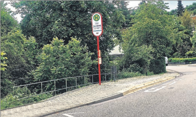
Die Bushaltestelle in der Niederjosbacher Straße in Bremthal ist barrierefrei umgebaut. Der stufenlose Einstieg in den Bus gelingt aufgrund der Höhengleichheit. Foto: Stadt Eppstein
