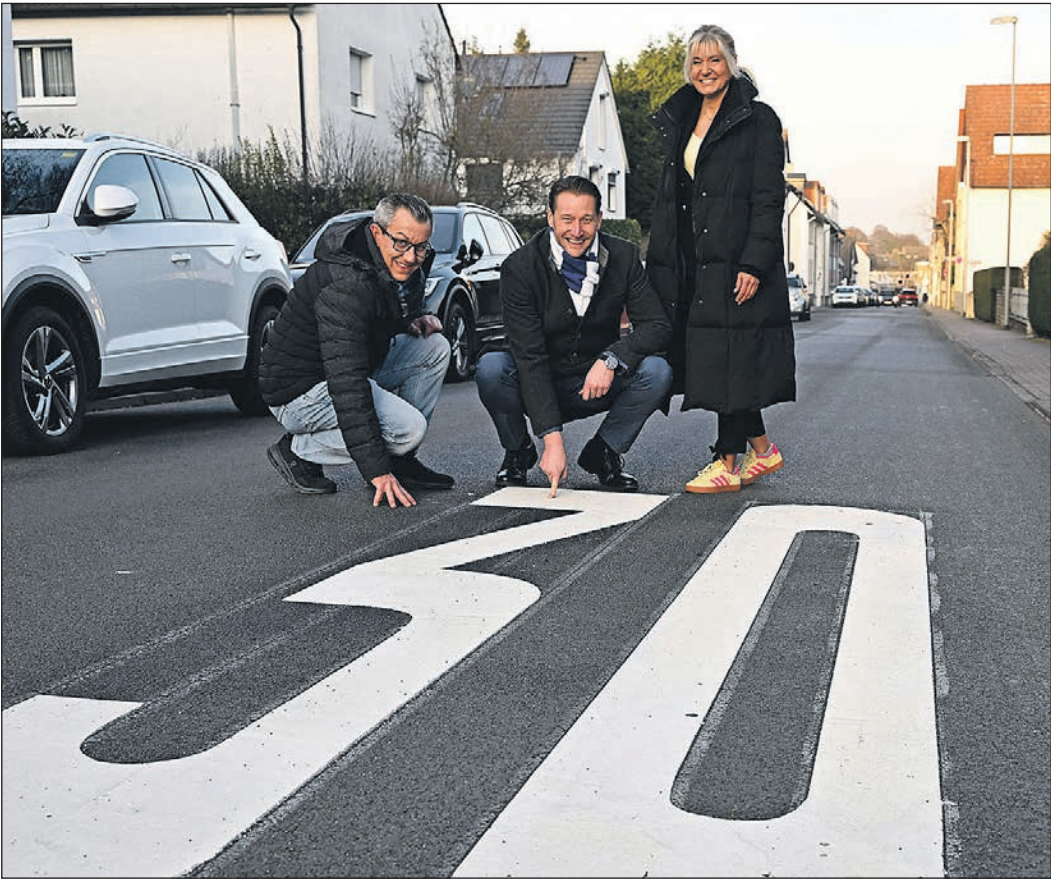
Die Fahrbahndecke und die Straßenmarkierung in der Jakob-Lengfelder-Straße ist erneuert worden. Foto: Stadt
