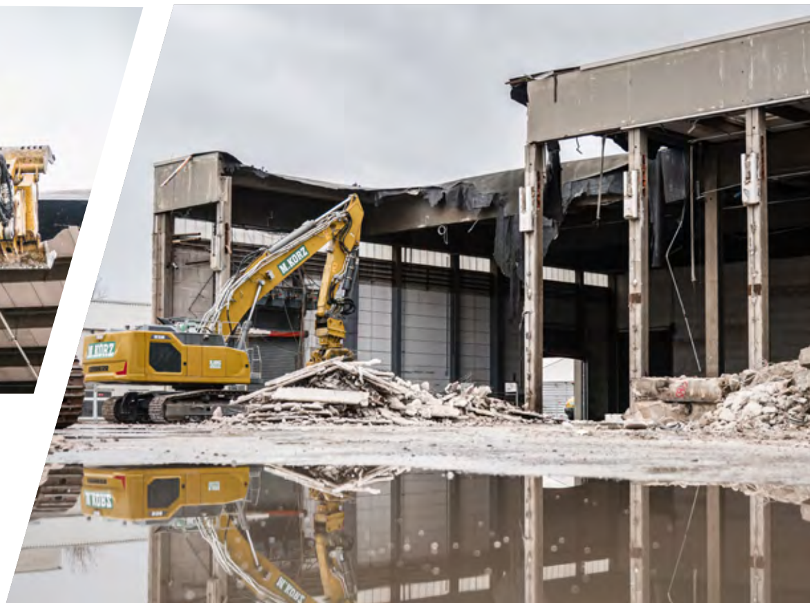
Mittels schwerer Geräte wird die Gebäudestruktur hydraulisch zurückgebaut. Fotos S.26: MAVI Media | Oliver Zimmermann
