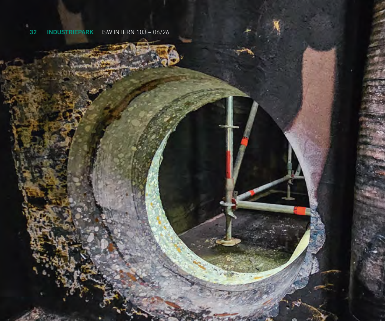
Schachtvergrößerung durch Kernbohrung DN 800.
