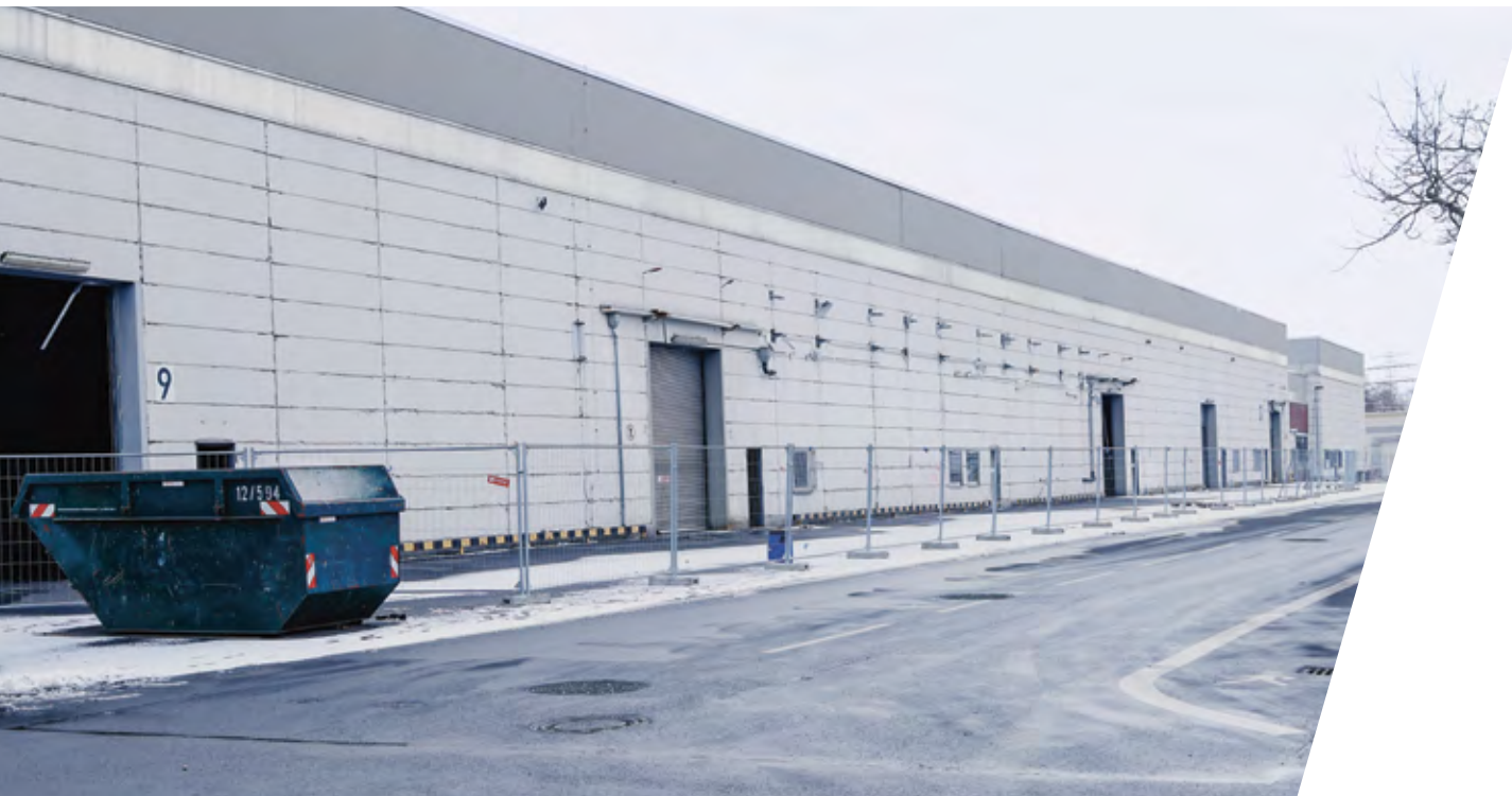
Die Lagerhalle B354 im Norden des Industrieparks Wiesbaden kurz vor dem Rückbau Anfang 2026.
