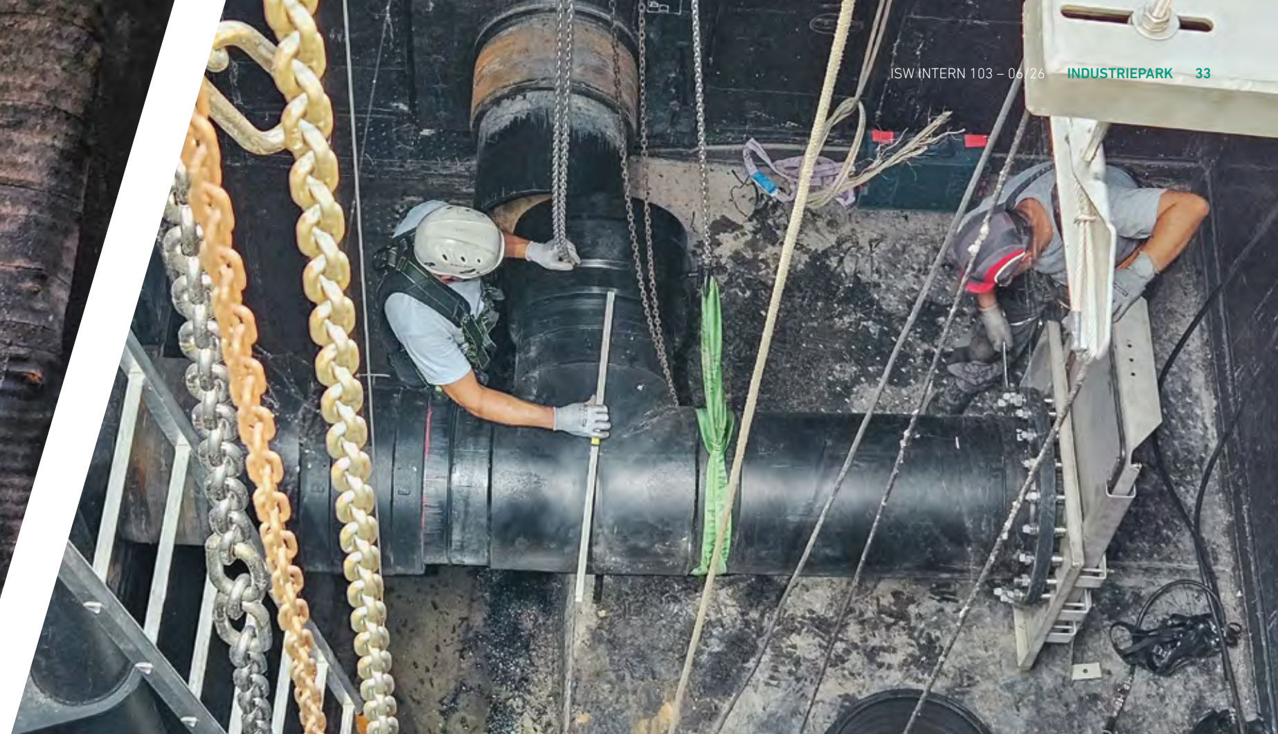
Rückbau nicht mehr verwendeter Anlagenkomponenten (Atlantikfilter).
