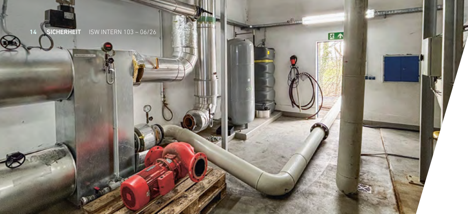
Anschluss der Ersatzanlage an das bestehende Heizsystem der Abwassererwärmung.
