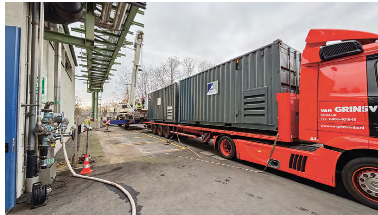
Anlieferung des neuen BARA-Heizsystems in Containern; im Hintergrund der Kran für den Entladevorgang.
