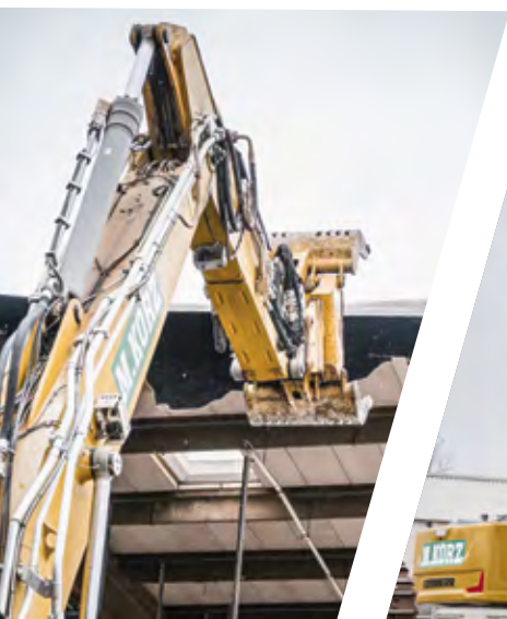
Mittels schwerer Geräte wird die Gebäudestruktur hydraulisch zurückgebaut. Fotos S.26: MAVI Media | Oliver Zimmermann
