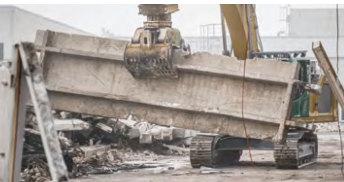
Mittels schwerer Geräte wird die Gebäudestruktur hydraulisch zurückgebaut. Fotos S.26: MAVI Media | Oliver Zimmermann
