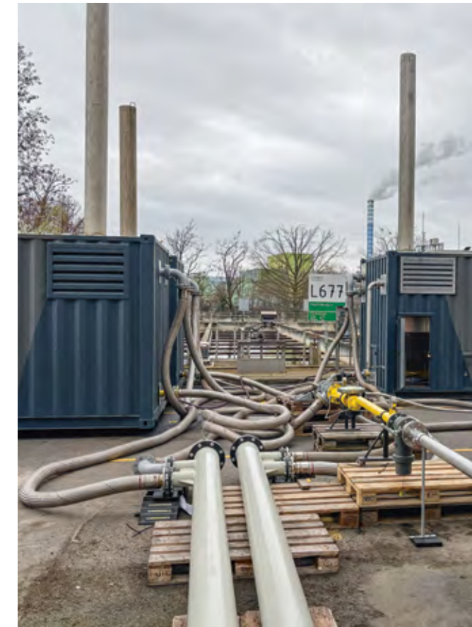
Installation der neuen Heizsysteme zur Erwärmung der Abwasserströme vor den biologischen Reinigungsstufen.
