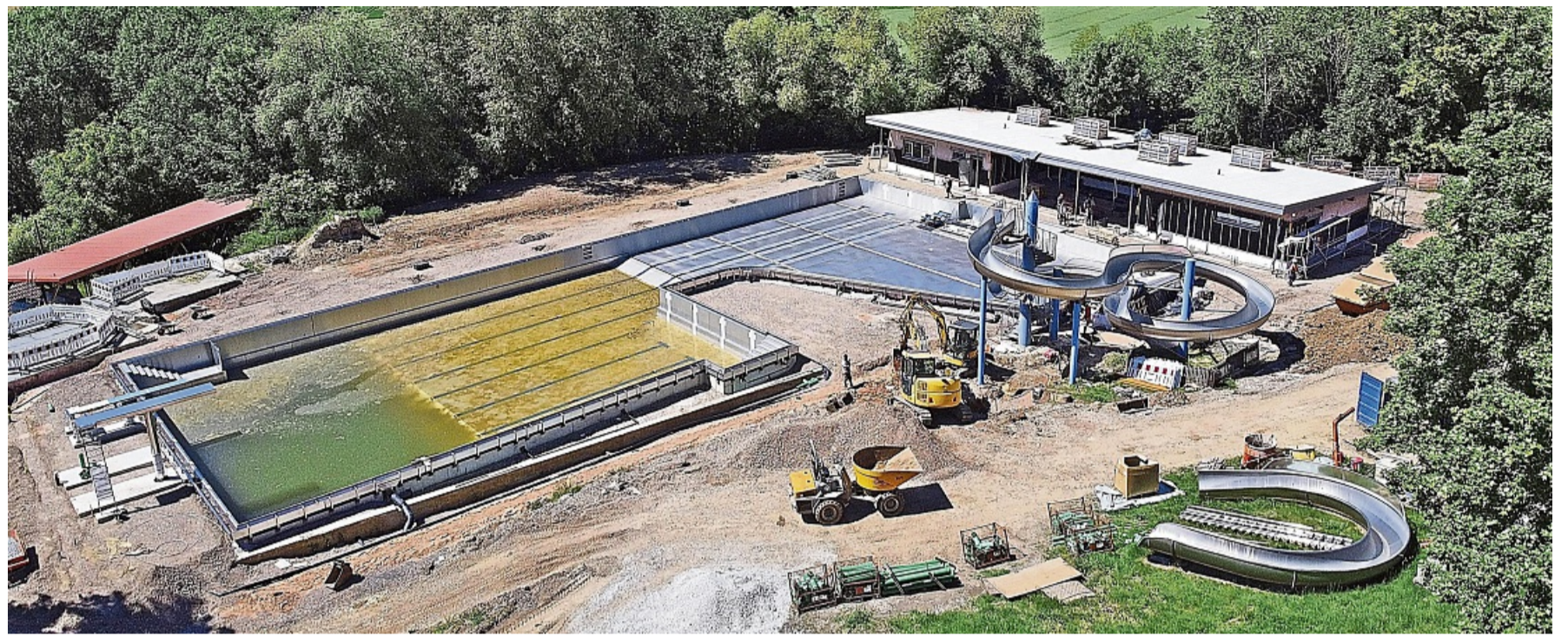
Eine große Baustelle: Das Freibad Erleborn in Homberg wird saniert.
