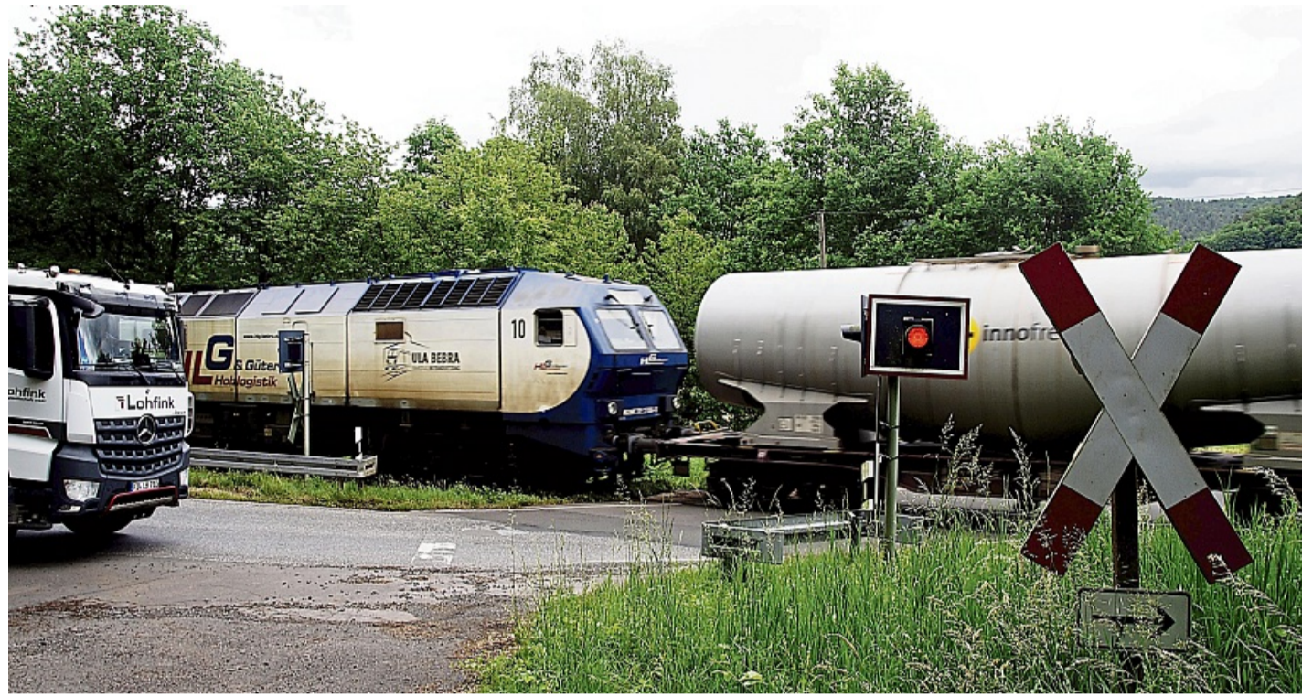
Der Bahnübergang zwischen Wölfershausen und Lengers soll im Zuge der Elektrifizierung mit Halbschranken ausgerüstet werden.
