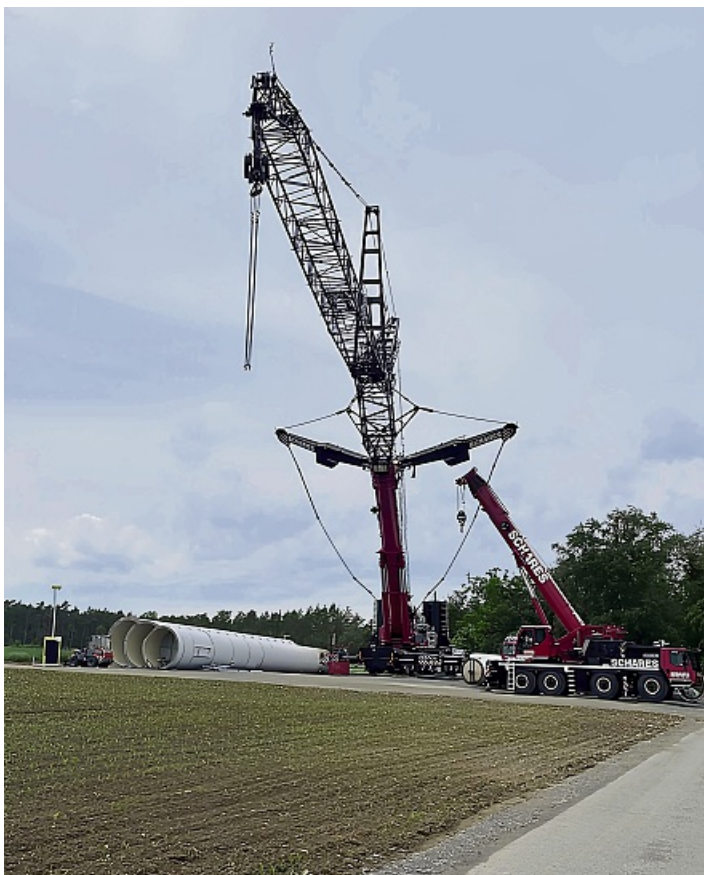
Rückbau: Eines der älteren Windräder am neuen Windpark Rhödaer Holz muss weichen. FOTO: WANDA CURIC
