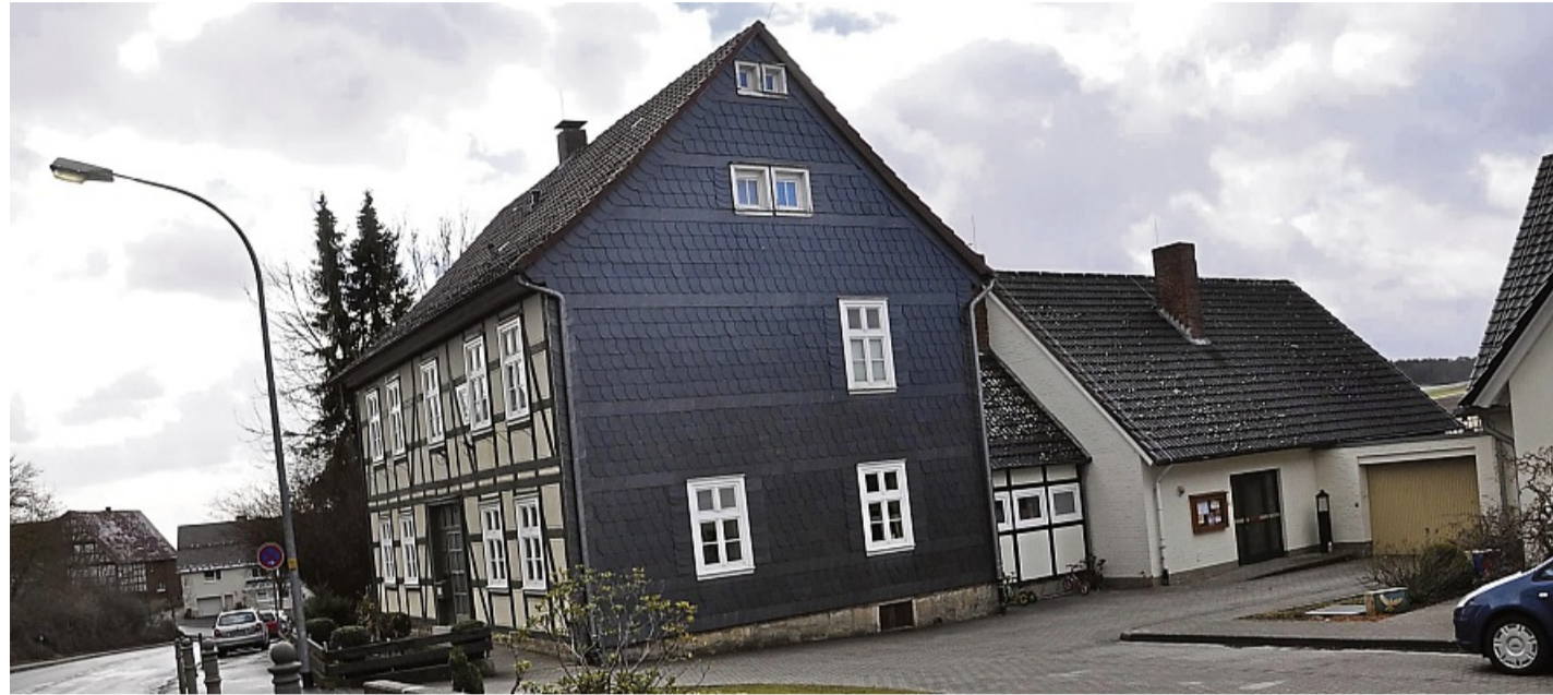
Um die Zukunft des alten Pfarrhauses in Goddelsheim zu sichern, könnte es vom restlichen Gebäudekomplex getrennt werden, indem der Zwischenbau abgerissen wird.
