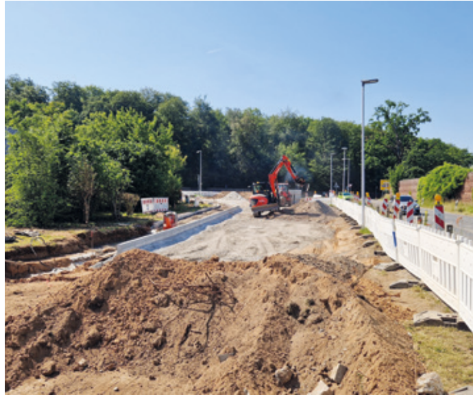
Der Neubau der Jägertorstraße zur Einmündung in die Kranichsteiner Straße (oben, vor Fasaneriewald) hat schon zügig Gestalt angenommen. Randsteine für den künftigen Gehweg sind bereits gesetzt (links). Die neue Jägertorstraße rückt in diesem Bereich dichter an Lidl. Bis zur Fertigstellung kann so die bisherige Jägertorstraße (rechts) in beiden Richtungen weiter befahren werden. Sie wird erst später zurückgebaut. (Fotos: dv)
