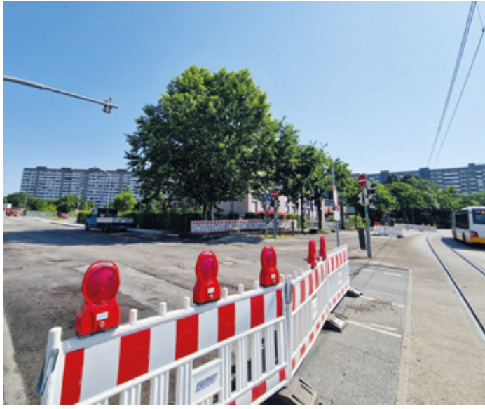
Blick von der Einmündung Siemensstraße auf den weitgehend fertigen Bauabschnitt der Jägertorstraße Richtung Kranichstein. Die Siemensstraße, in die gerade ein Bus fährt, wird dann für die Umleitung gebraucht.
