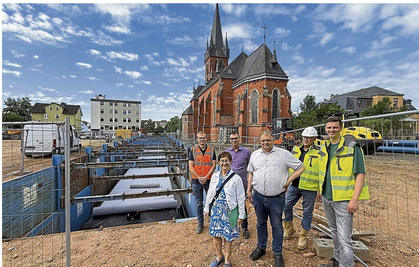
Rückhaltebecken an Puffer für Extremwetter: (von links) Mirco Hofmann (Bickhardt Bau), Bürgermeisterin Anke Hofmann, Jörg Albin (ProjektStadt), Johannes van Horrick (Stadt Bad Hersfeld), Joachim Oster (agc) und Leon Daum (agc) vor der sogenannten Rigole.
