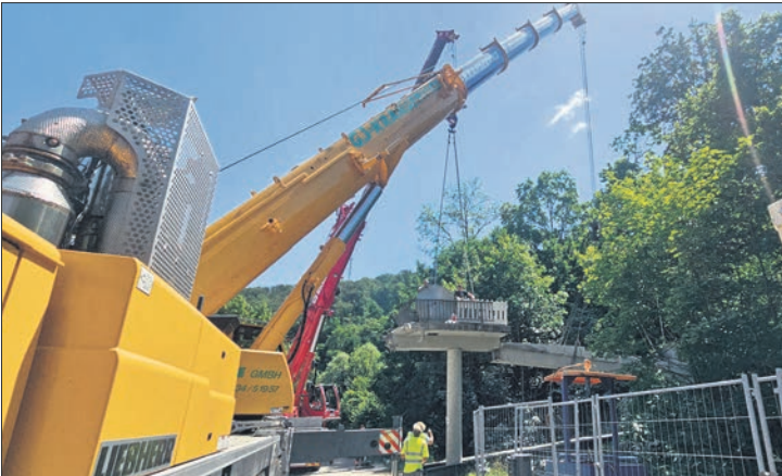
Stück für Stück wird die Brücke innerhalb einer Woche zerlegt und die Baustoffe getrennt.
