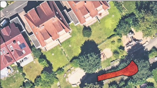
Das Rückhaltebecken in Bremthal Auf dem Hecken (rot markiert) wird saniert. Foto und Skizze Stadt Eppstein
