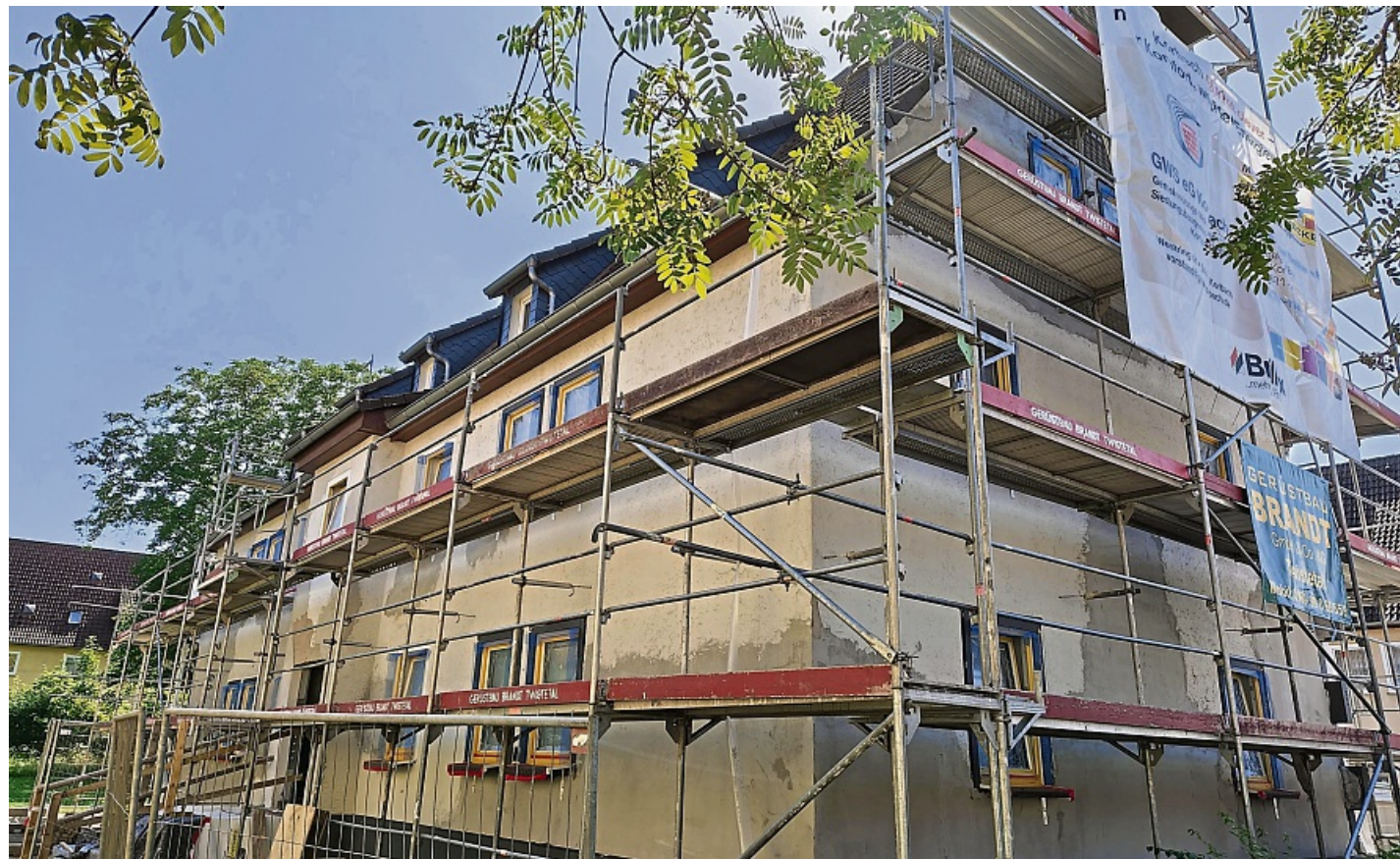
Außendämmung und neue Fenster: Die GWS modernisiert gerade dieses Haus in der Schlesischen Straße. FOTO: DENNIS SCHMIDT
