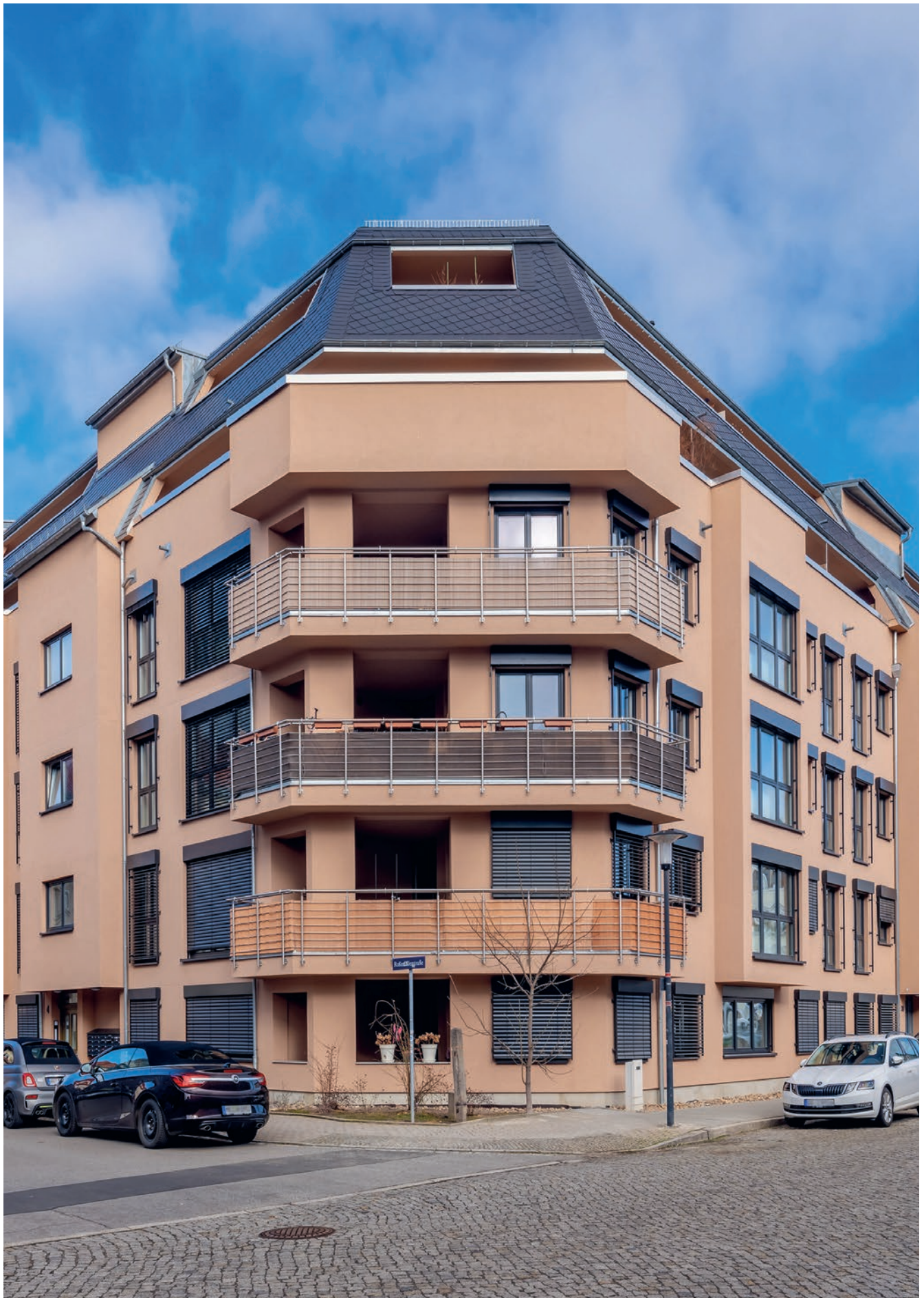
Dresden, Roßmählerstraße / Rietzstraße
