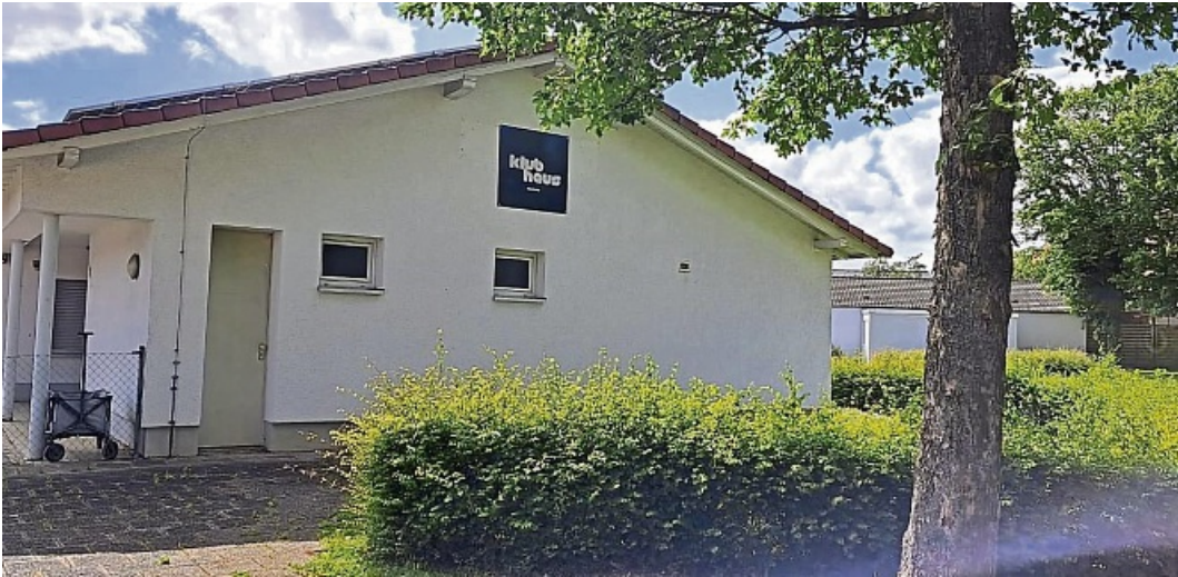
Früher war es eine Umkleidekabine: Jetzt ist das Klubhaus für alle Vereine nutzbar. Vor der Eröffnung wurde den Innenräumen ein frischer Anstrich verpasst.
