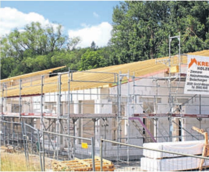
Der Dachstuhl am neuen Kindergartengebäude fehlte noch beim Richtfest und ist jetzt errichtet.
