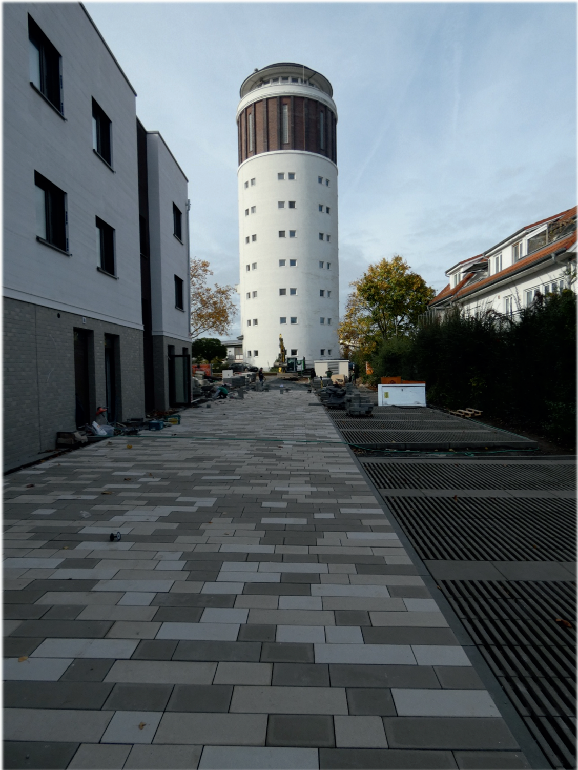
Feuerwehruzufahrt und Parkplätze mit Blick auf den Wasserturm
