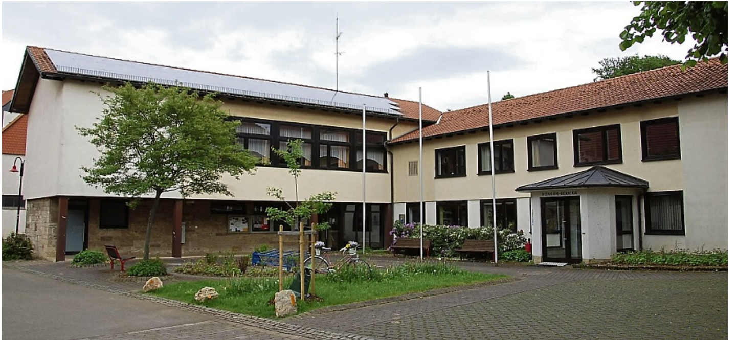
Die Sanierung des Adorfer Dorfgemeinschaftshauses kann beginnen: Der Gemeindevorstand hat die ersten Aufträge vergeben. Knapp eine Million Euro sind für die Bauarbeiten veranschlagt. FOTOS: KARL SCHILLING
