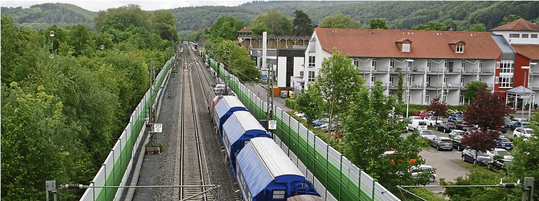
Doppelter Schallschutz: Die Bewohner des unmittelbar benachbarten Geriatrie-Zentrums dürfte es freuen.
