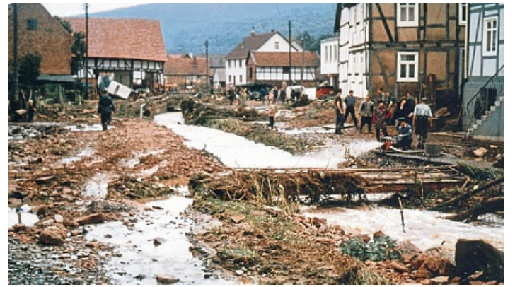
Die Hauptstraße durch Rhina ist nach dem Hochwasser 1966 zerstört. Das weiße Auto, das im Hintergrund quer an der Scheune lehnt, war frisch gekauft. FOTO: HAUNETAL
