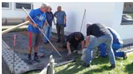
Auch die Arbeiten an der Terrasse gehen voran
