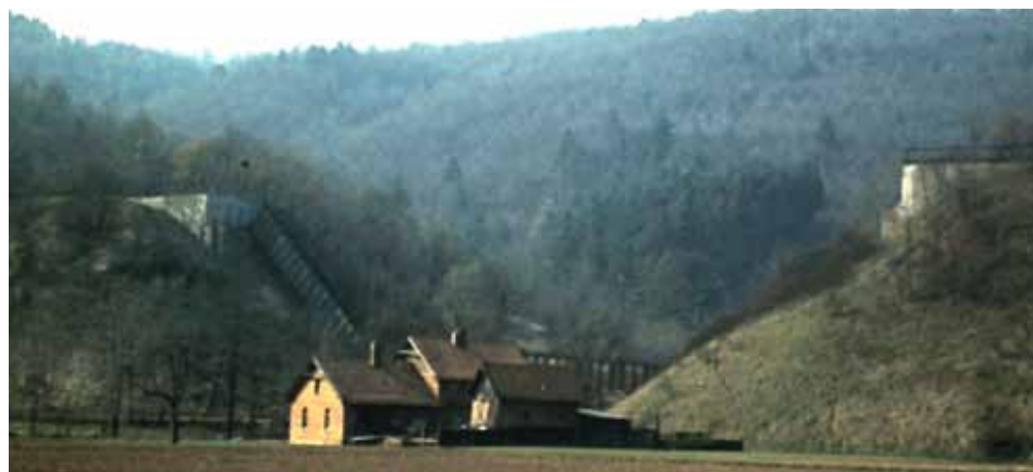
Das Frieda-Viadukt mit herunter hängendem Überbau um das Jahr 1970
