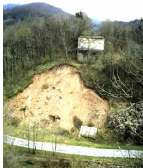
Die Reste vom östlichen Widerlager um 1990. Im Vordergrund liegt noch ein Betonblock vom ehemaligen Brückenpfeiler Foto: Dieter Rüsck
