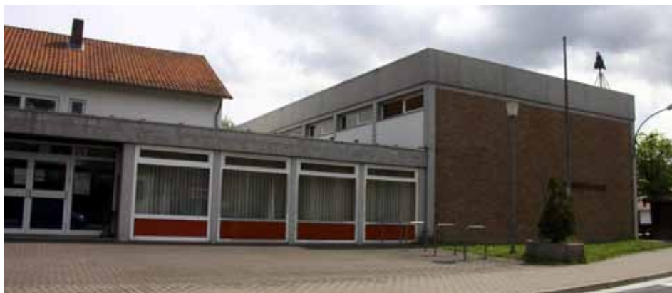
Die Weinberghalle vor der Sanierung um Jahr 2018
